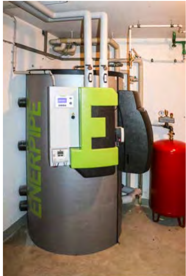
Abb. 1: Installiertes Pufferspeichersystem
