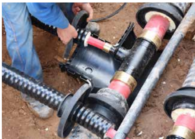
Abb. 4: Montage CaldoCLICK Muffe im Bestand (Muffendichtgummi)
