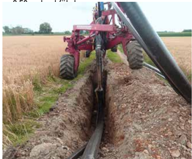
Abb. 27: Pflugverlegung
