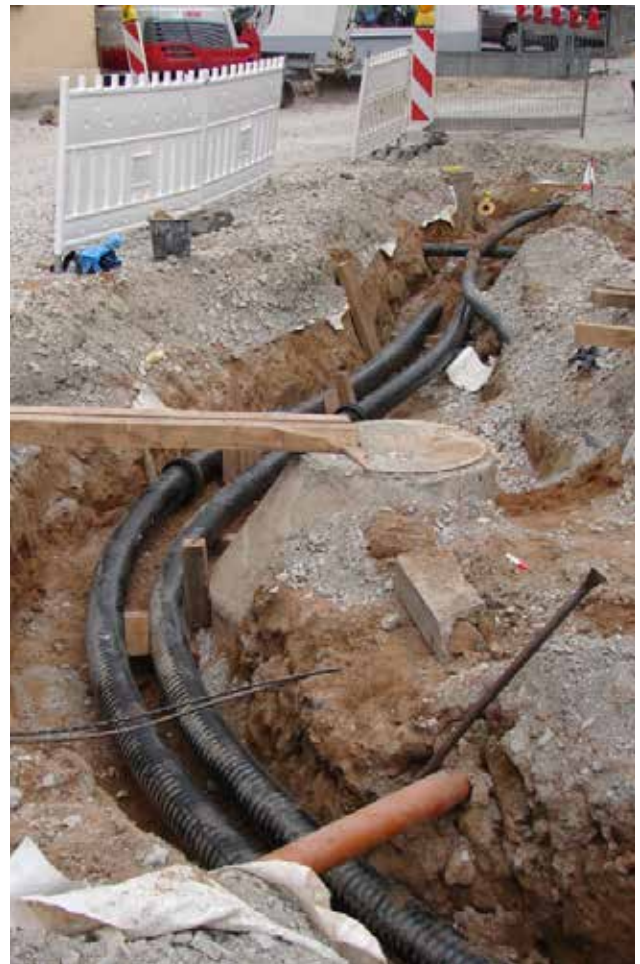
Abb. 2: Verlegung in der Praxis
