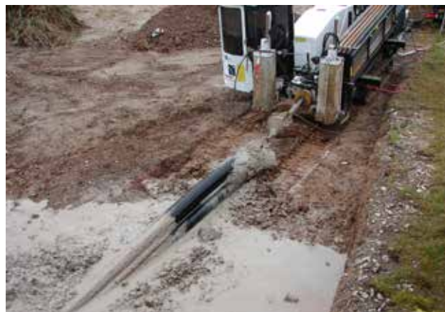
Abb. 29: Spülbohrgerät mit Rohren in der Startgrube
