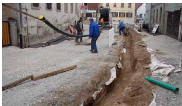
Abb. 30: Offener Rohrgraben und Abwickelvorrichtung
