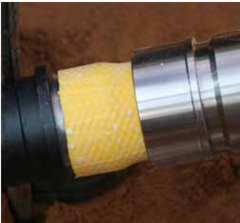
Abb.34: FibreFLEX -Rohr vor dem Verpressen
