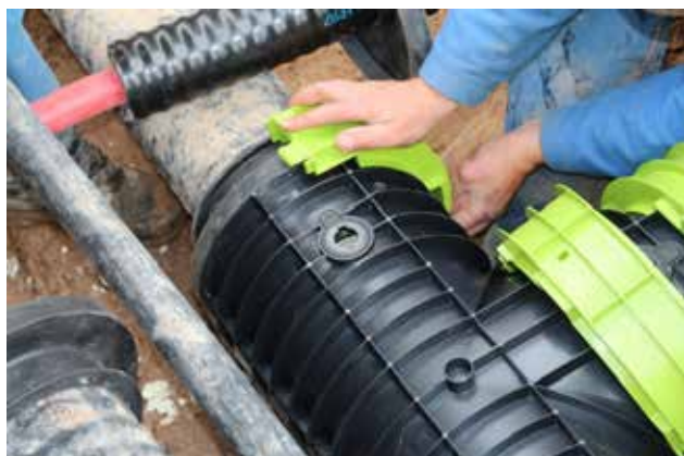
Abb. 3: Montage CaldoCLICK Muffe im Bestand (Verschlussring)
