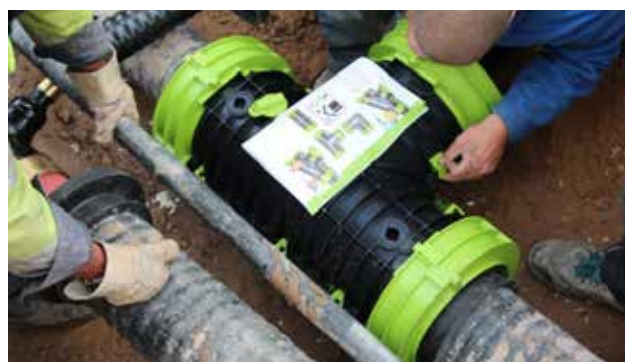
Abb. 5: Montage CaldoCLICK Muffe im Bestand (Einsteckclip)
